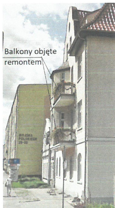
Elewacja widok od Alei Tysiąclecia
